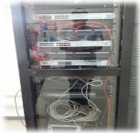
Figura 10. Rack con switches de comunicación.
