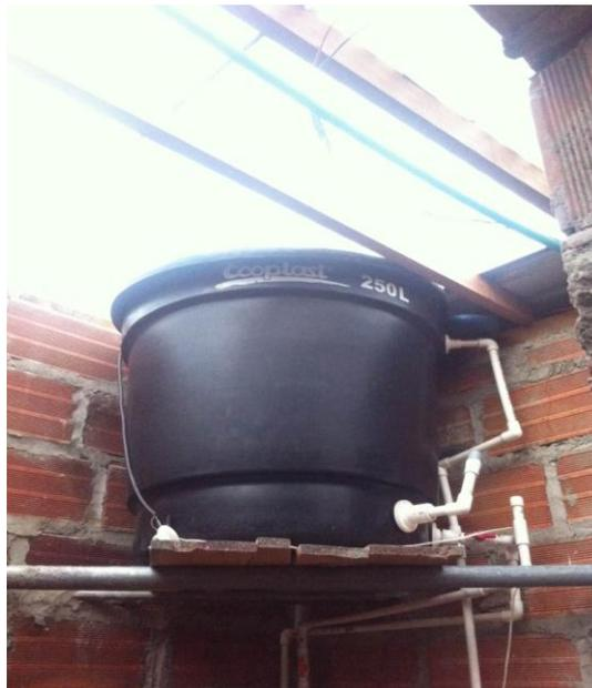
En algunos casos los tanques desprenden parte de su material y por esta razón tuvimos mucha precaución al momento de la elección, de igual manera con los demás componentes de este proyecto, como lo fue también la tubería que se decide por utilizar tubería pvc ya que si utilizamos otro tipo de tubería por ejemplo la galvanizada podríamos contar con que se nos puede oxidar y esto empeoraría el sistema, por esta y más razón la mejor opción fue la tubería pvc.
