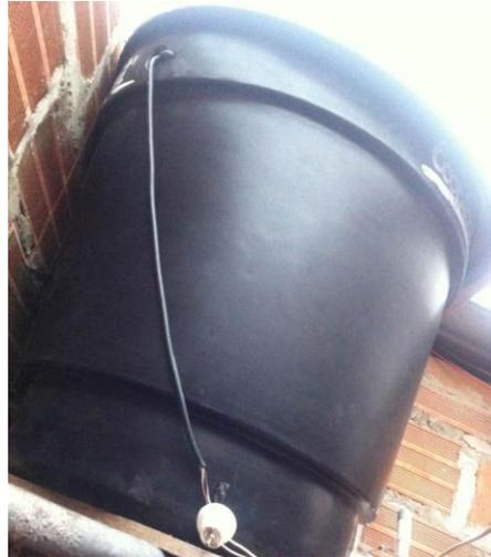
Continuando con la distribución de la tubería pasando por cada uno de los pisos se llega a la motobomba y a la electroválvula que de allí se acopla a la tubería principal que es la que distribuye el agua en el barrio (tubo madre), teniendo la parte de la tubería distribuida, se conecta la parte eléctrica desde la electroválvula que se encuentra en el primer piso hasta el tanque que está en el tercer piso pasando por cada uno de los componentes que intervienen eléctricamente.
