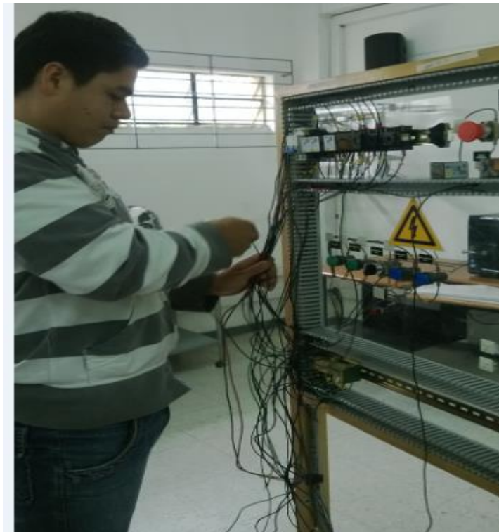
Figura 29 Cableado del módulo
