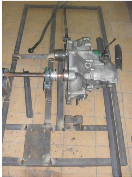
Foto 42 Soldando estructura y alineando caja
