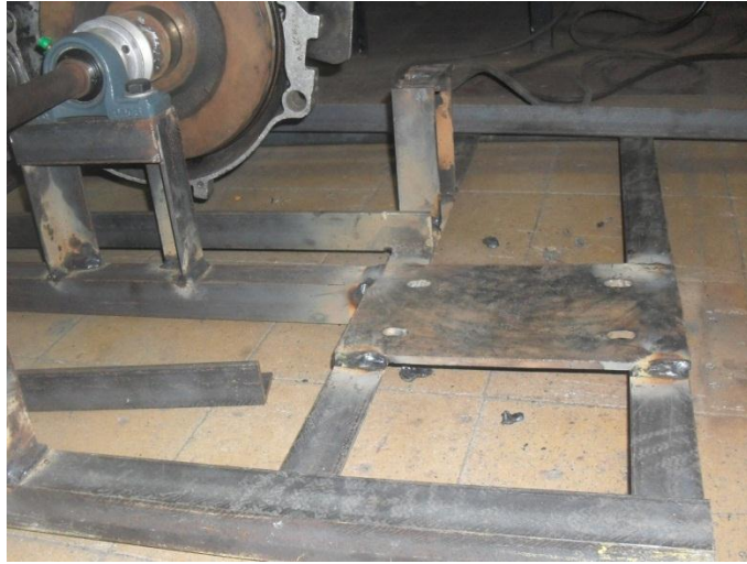
Foto 41 Soldando base del motor
