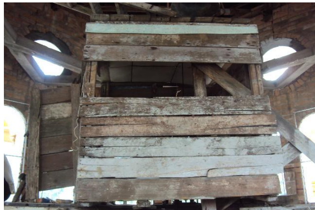
Figura 4. Armazón que protegía al mecanismo del reloj
