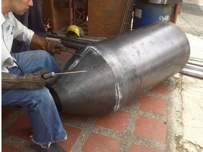
Figura 33. Soldado de estructura
