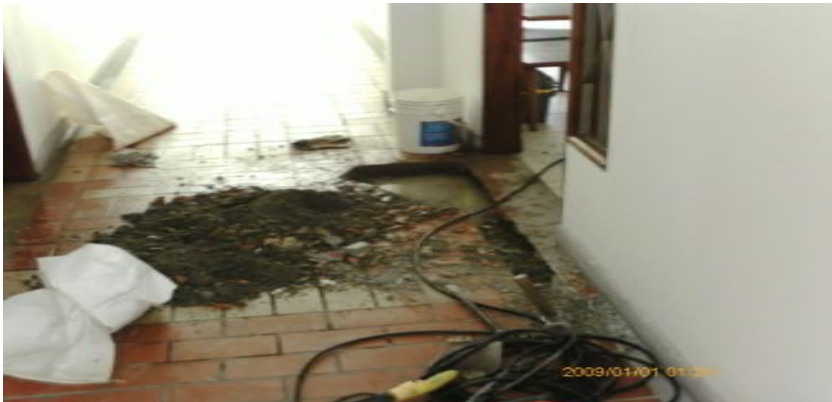
Figura 4 Exploración con roto martilló en concreto reforzado
