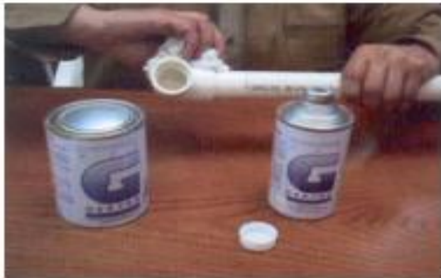
Figura 7 Utilización de soldadura y limpiador
