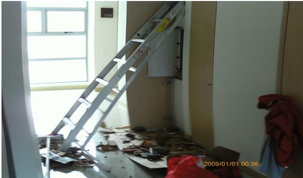
Figura 3 Exploración en muro afectando en ladrillo
