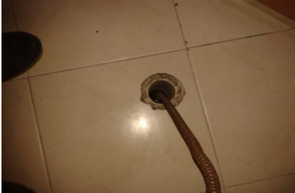
Figura 9 Destaponamientos con maquinaria K50
