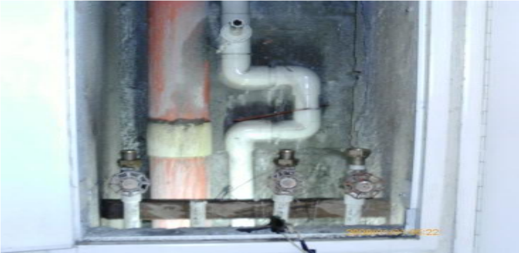
Figura 5 Corte de tubería
