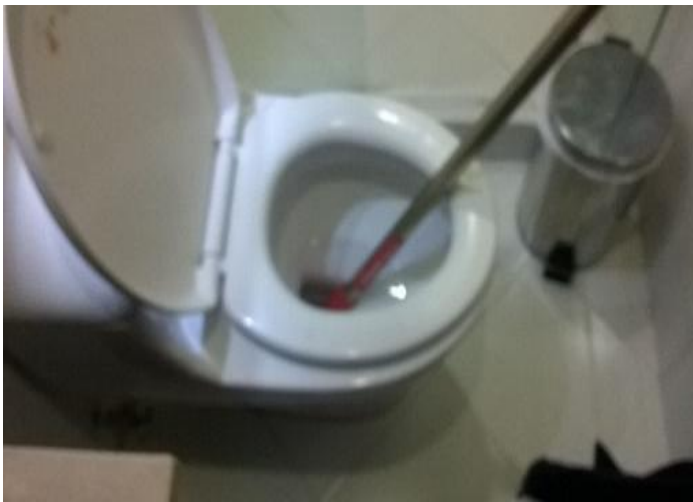
Figura 10 Destaponamiento en sanitario con barreno
