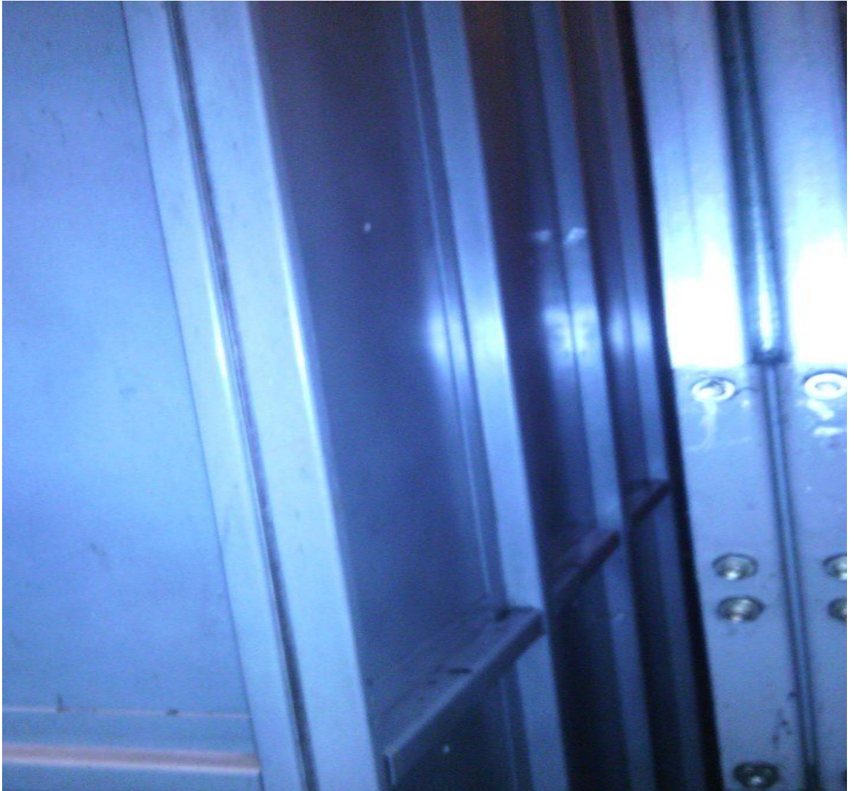
Figura 14: Espacio que se debe asear entre el ascensor y la pared del hueco
