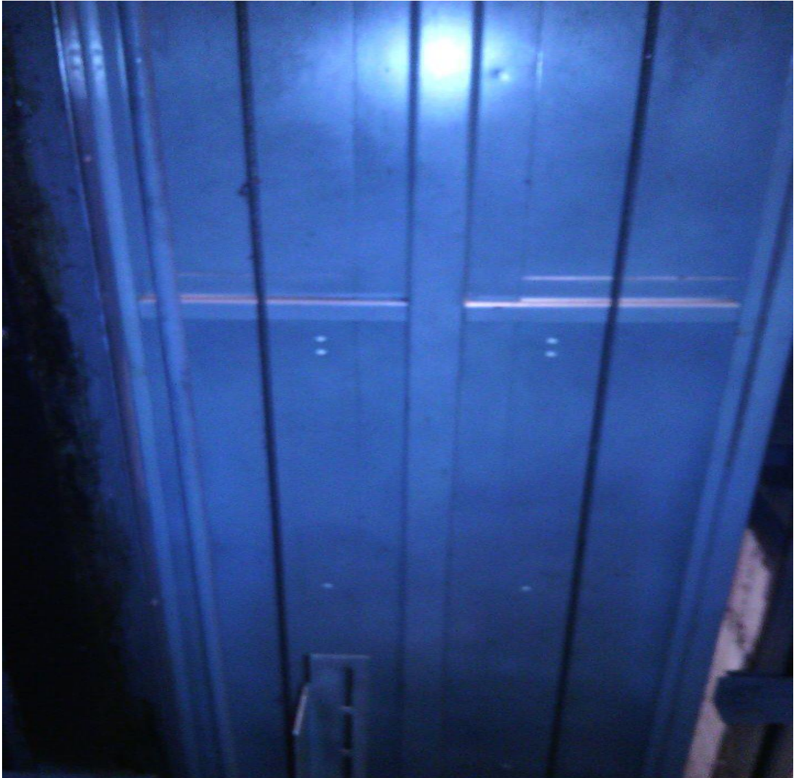
Figura 13: Paño exterior lateral izquierdo
