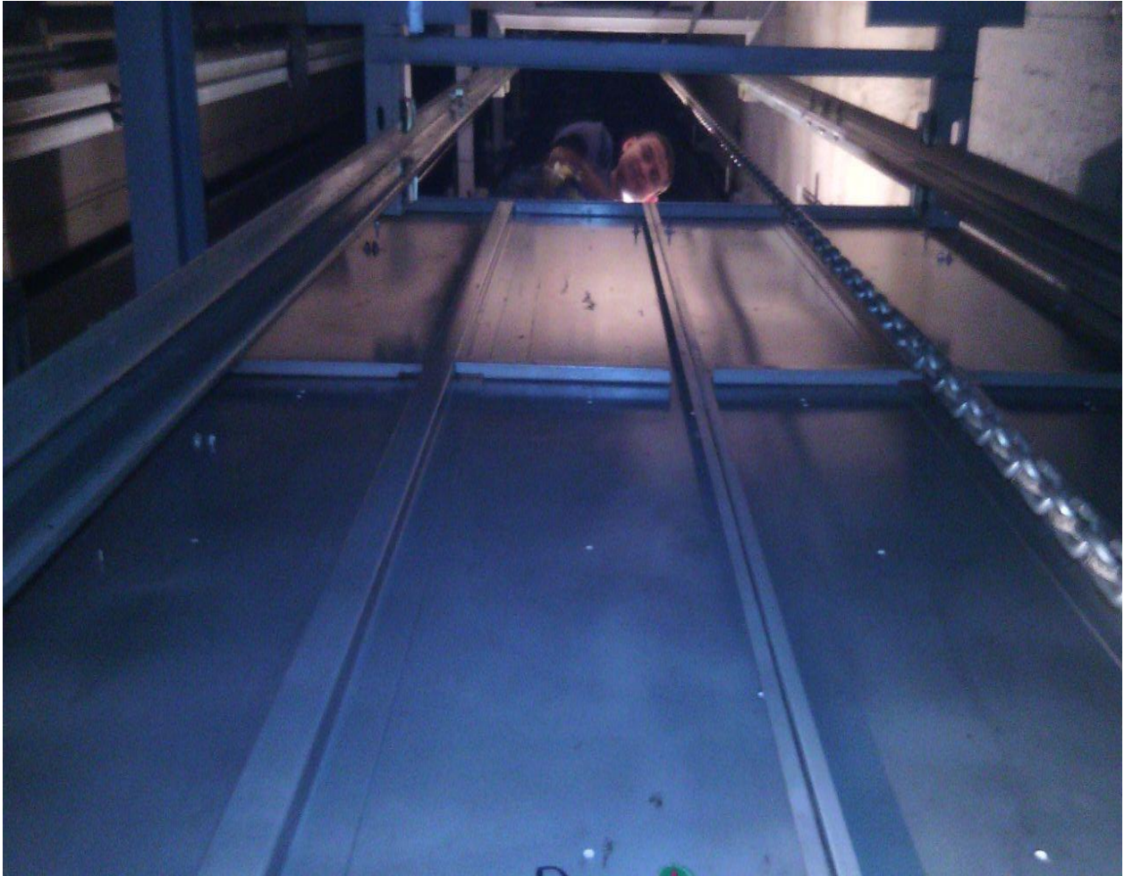
Figura 15: Altura de los paños exteriores centrales de los ascensores
