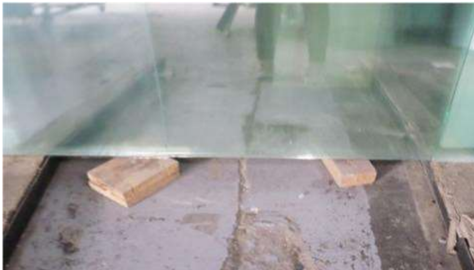
Imagen 3. Ubicación y modo de colocar el material
