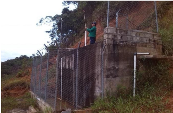
Figura 1. Tanque de almacenamiento y distribución nro. 2
