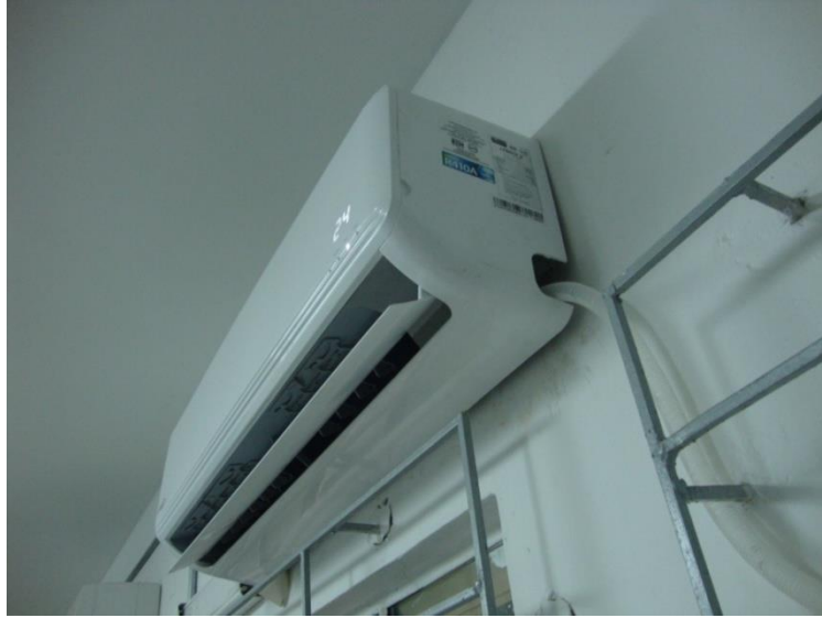
Ilustración 17 Unidad exterior evaporadora
