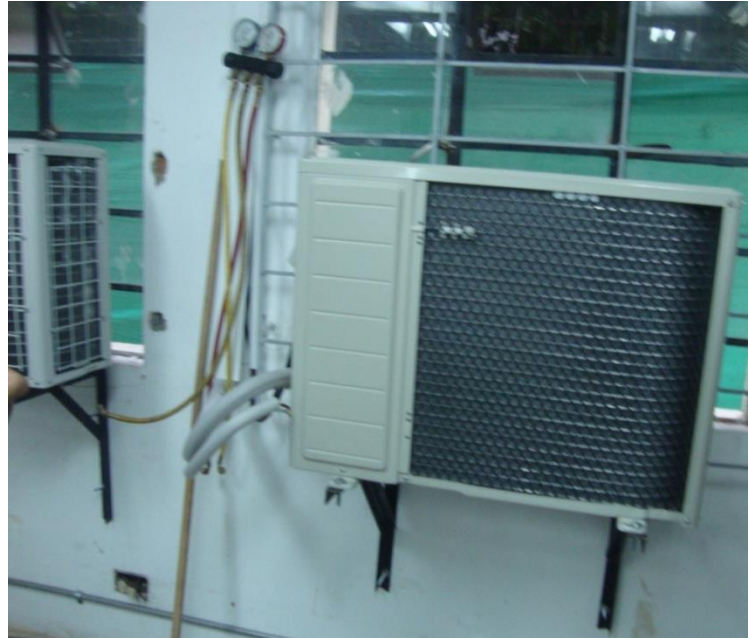
Ilustración 16 Unidad interior condensadora
