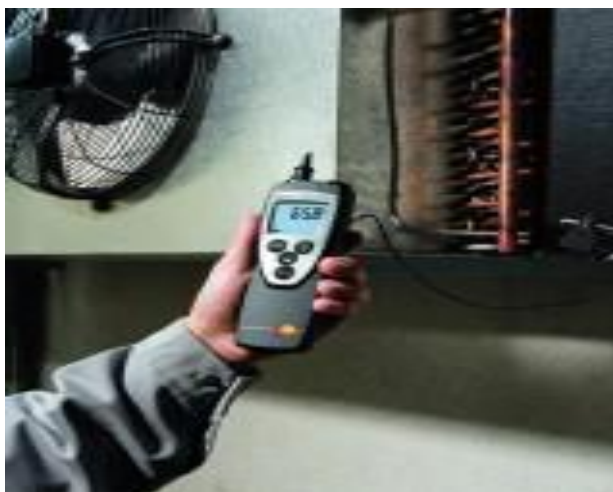
Ilustración 5 Medición de temperatura en cámara de refrigeración
