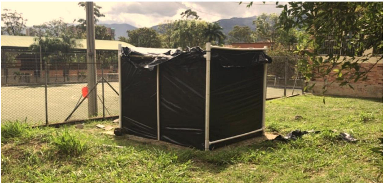
Figura 9. Marquesina terminada Fuente: propia
