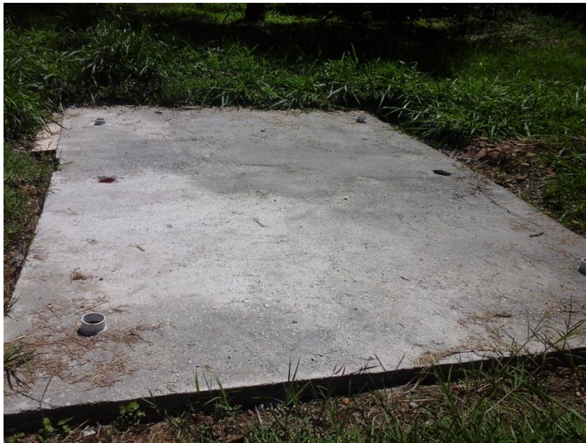
Figura 3. Base de la marquesina.
