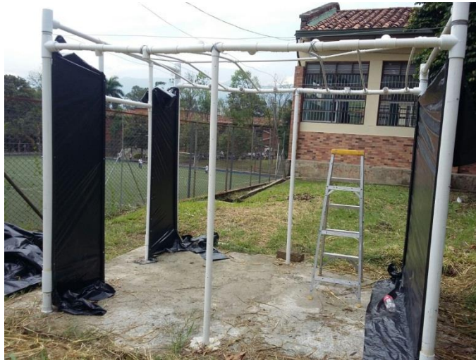
Figura 8. Parte delantera y trasera cubierta con el plástico de polietileno. Fuente: propia
