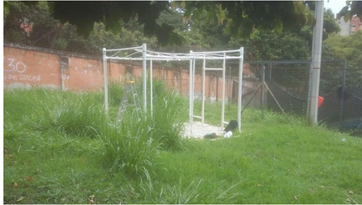
Figura 6. Estructura externa de la marquesina.
