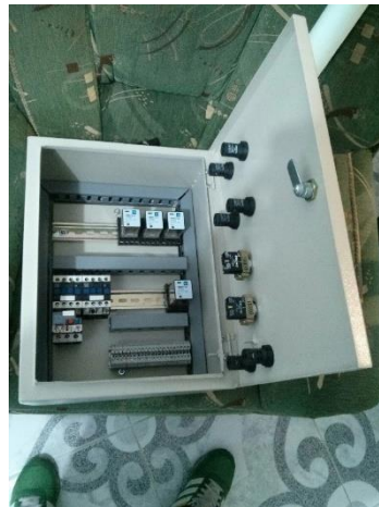
Figura 36. Gabinete acondicionado para cablearlo Fuente: propia
