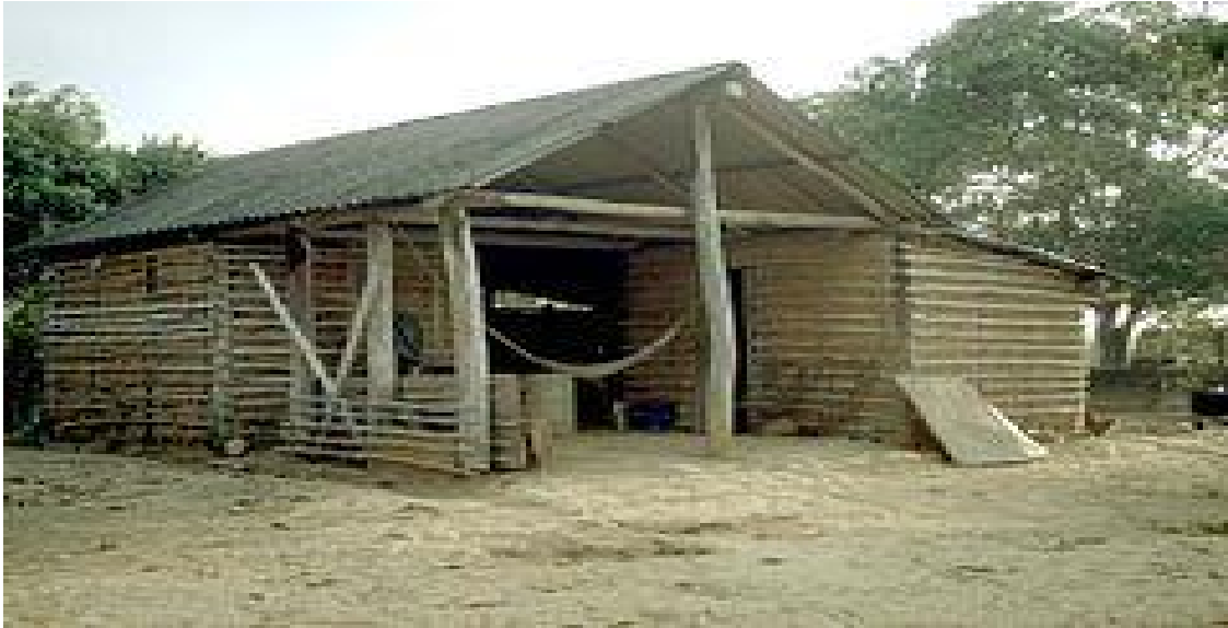
Ilustración 7 Construcción en bahareque
